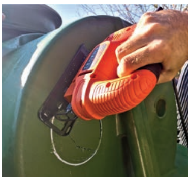
4. Bauseitiges Schneiden mittels einer Stichsäge
