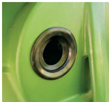
5. Einsetzen der Lippendichtung für Zulauf, Überlauf, Medium-Rohre
