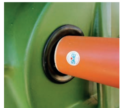
6. Montage des Zulauf- Überlauf- bzw. Medium-Rohres
