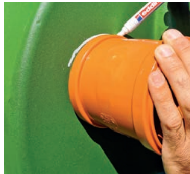
2. Markieren des Schneidekreis an einer glatten PE-Tankfläche
